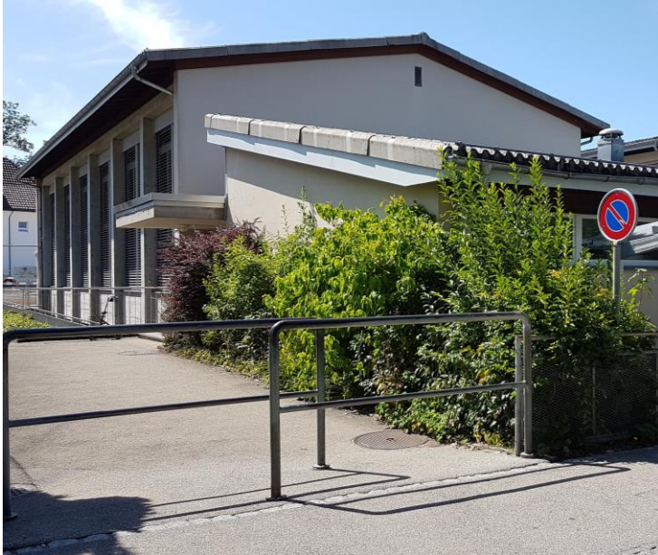
Turnhalle am Reinhardweg
